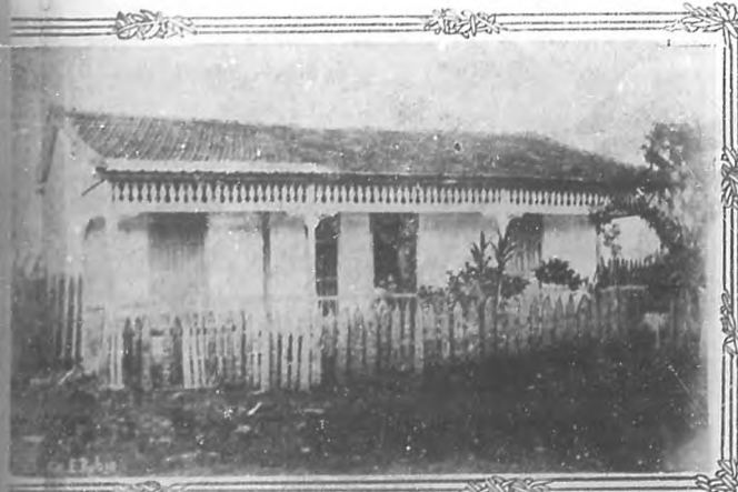
Casa vivienda del Sr. Cándido Morales en la Finca "Lengua de Pájaro"
